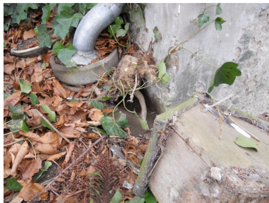
BILLEDE 67 ET ROTTEHUL UDEN JORDFANE PÅ EN BEBOELSESEJENDOM, HVOR DER ER KLOAKERET, ER NORMALT ET TEGN PÅ KLOAKBRUD.
