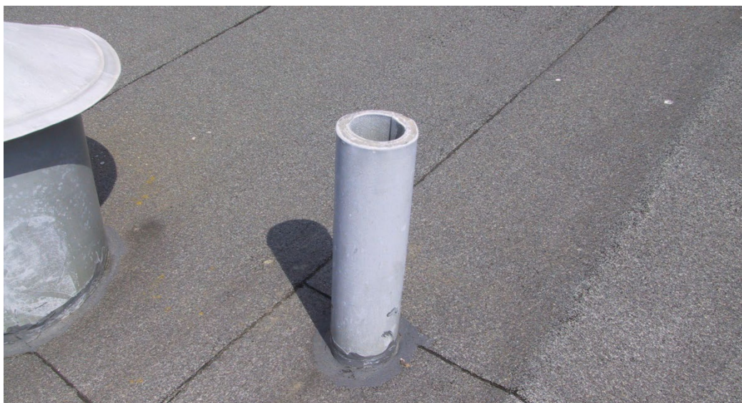
BILLEDE 6 EN USIKRET FALDSTAMMEUDLUFTNING KAN OFTE VÆRE ÅRSAG TIL ROTTER I BYGNINGER OG BOLIGER.
