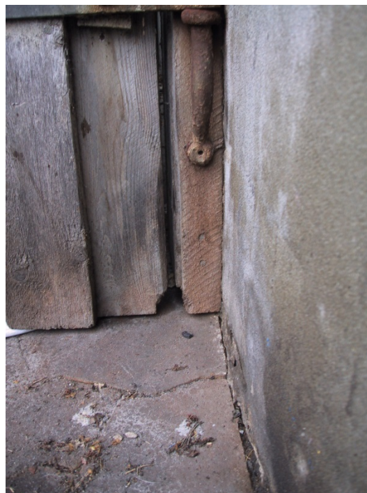
BILLEDE 53 ROTTEHUL I TRÆBEKLÆDNING, HVOR HULLET ER GNAVET UDEFRA.
