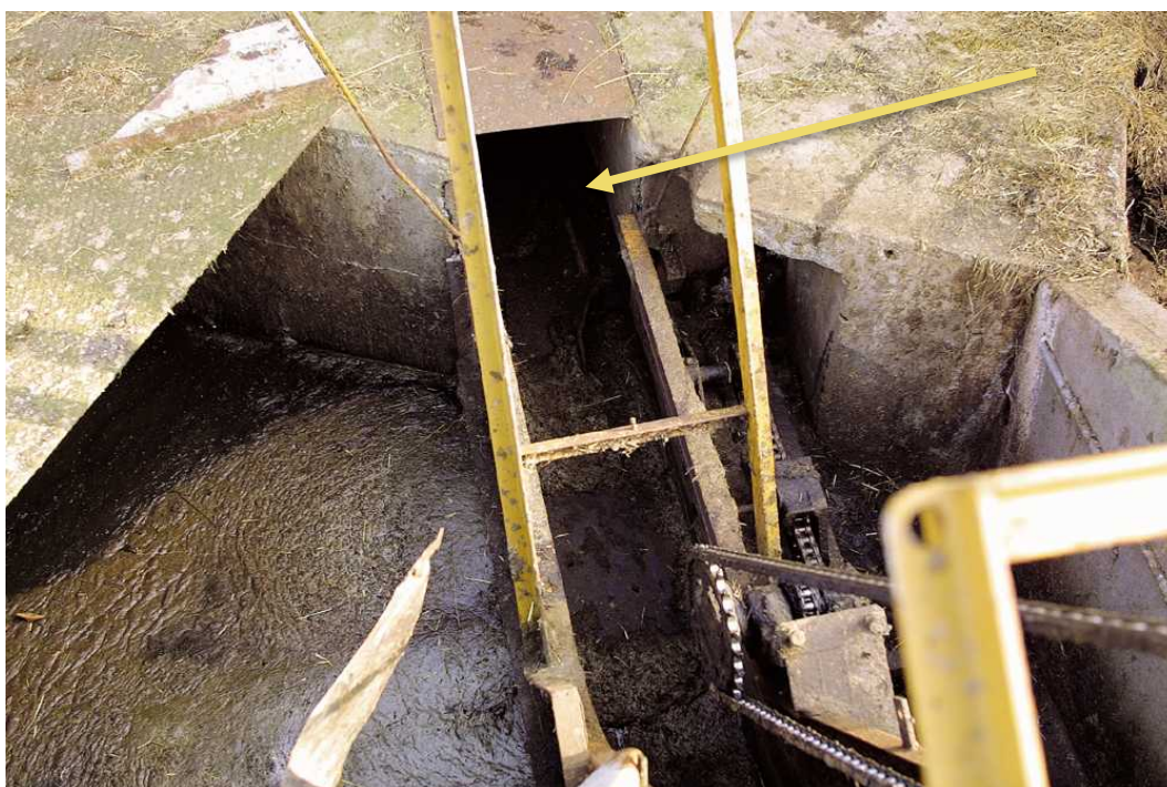
BILLEDE 10 EN UDMUGNINGSKANAL I FORBINDELSE MED EN STALD SKAL VÆRE SIKRET MED KLAP EL. LIGN. VED UDMUNDINGEN.
