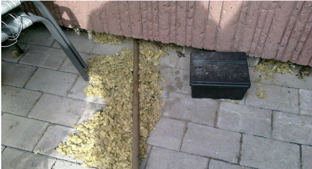
BILLEDE 35 EN SIKRINGSORDNING OM FOREBYGGELSE OG BEKÆMPELSE AF ROTTER OMFATTER EN GENNEMGRIBENDE BYGNINGSGENNEMGANG
