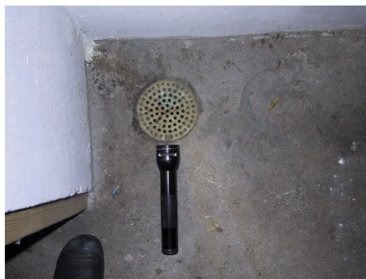
BILLEDE 70 GULVAFLØB AF PLASTIK SIKRER IKKE EFFEKTIVT MOD ROTTER.
