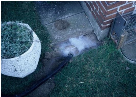
BILLEDE 72. VED MISTANKE OM KLOAKFEJL PÅ EN EJENDOM MED ROTTER SKAL DEN AUTORISEREDE PERSON ALTID FORETAGE EN RØGPRØVE AF KLOAKSYSTEMET.
